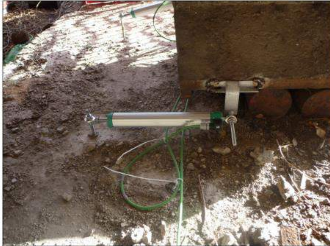
Fessurimetro MG10 su appoggio di valle della 4 ° cam pata lato Savona.
