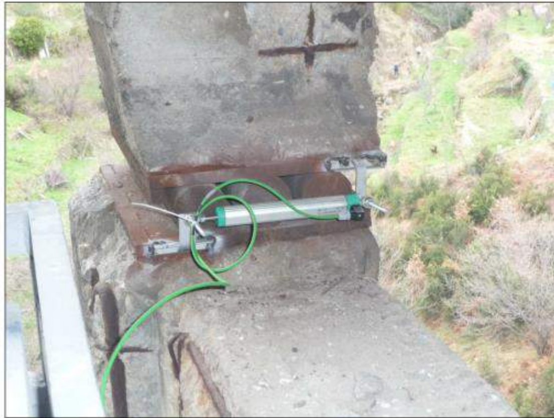
Fessurimetro MG8 su appoggio di monte della 3 o camp ata lato Savona.
