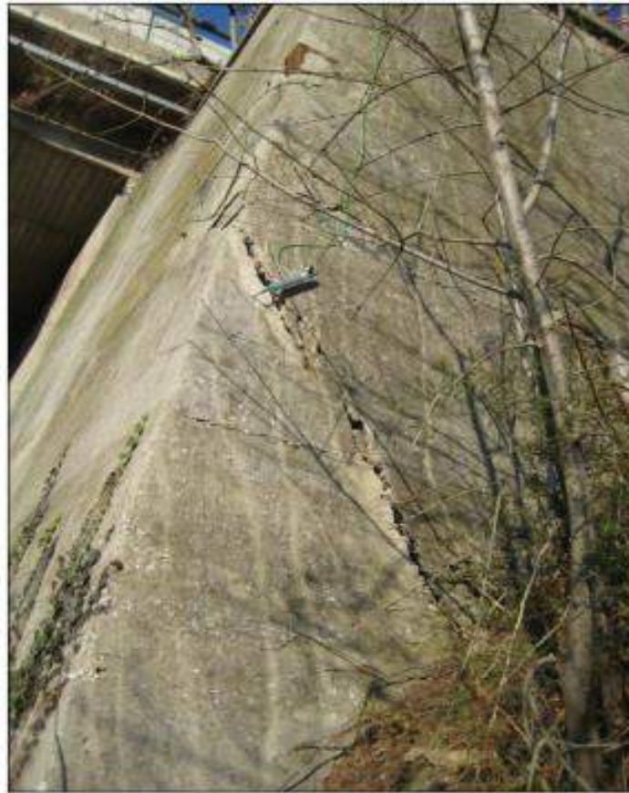
Lato di valle della spalla del viadotto; frattura monitorata con MG4.
