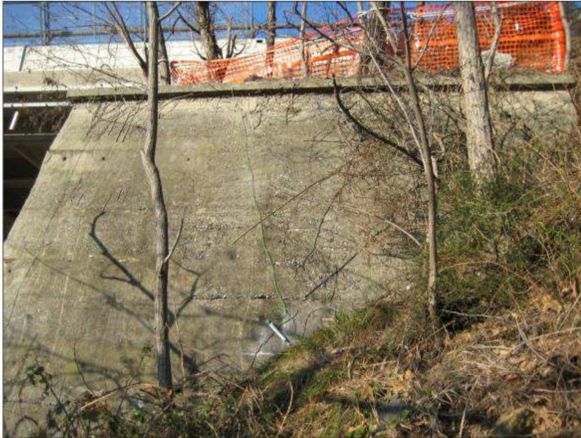
Lato di valle della spalla del viadotto; frattura monitorata con MG3.
